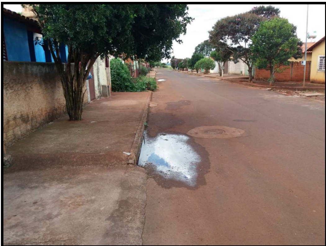
FOTO 2: empossadas e não escoam para as Bocas-de-lobo.
