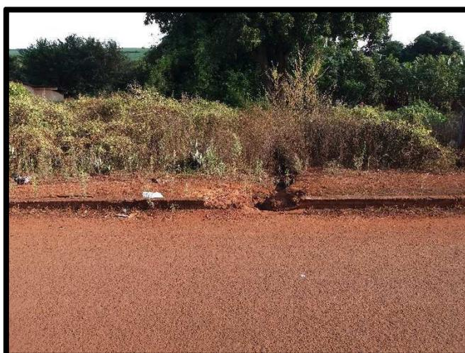
**FOTO 15: meio-fio quebrado para escoar enxurrada**
