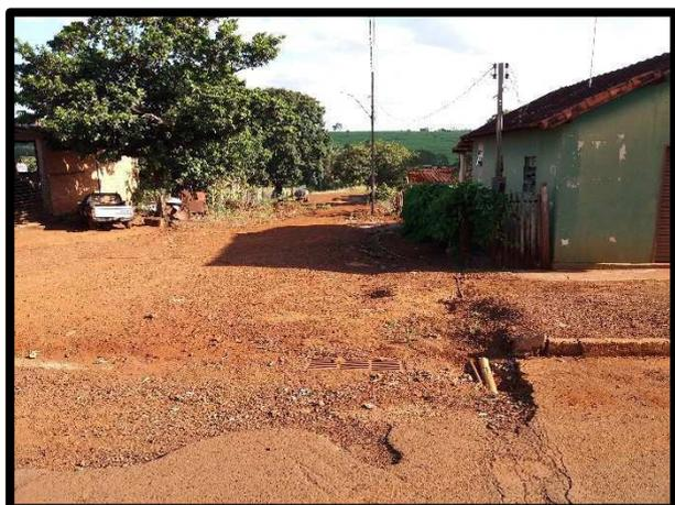
**FOTO 14: meio-fio quebrado para escoar enxurrada**
